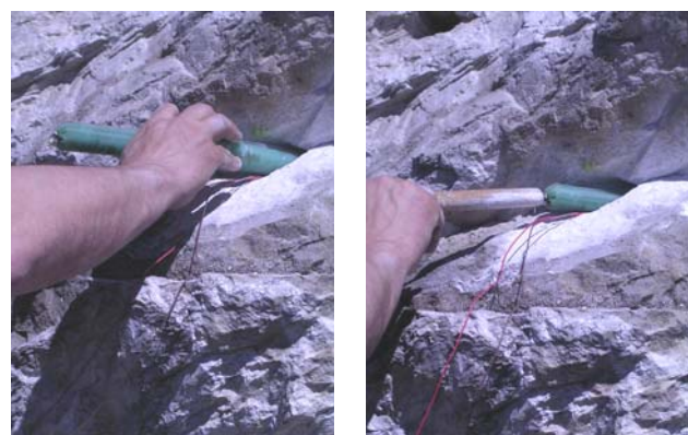
Brillamento di una mina da 0.61 kg
